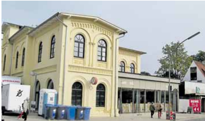
Der S-Bahnhof Blankenese wird 2013 weiter behindertengerecht umgebaut.
